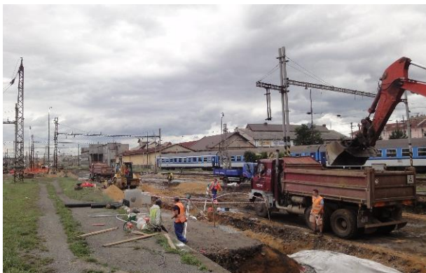
Obr.1: Snímek z rekonstrukce východní části železniční stanice Plzeň hlavní nádraží
