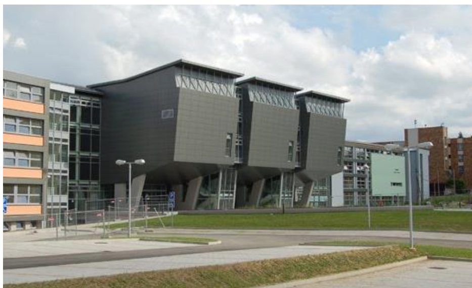
Obr. 1 – Pohled na centrální část Žilinskej univerzity na Veľkom dieli v Žilině
