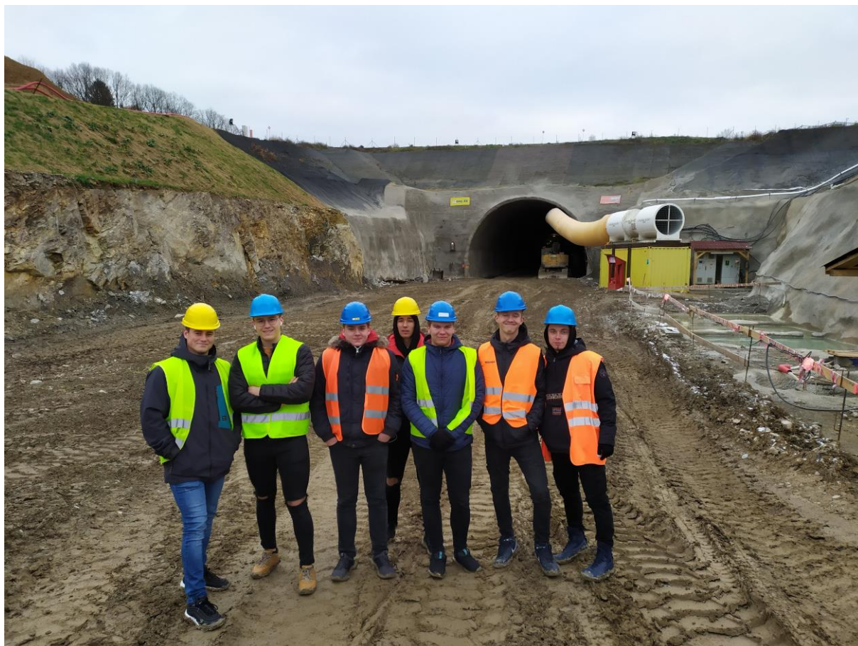
Obr. 2: Exkurze studentů – IV. železniční koridor v úseku Sodoměřice – Votice
