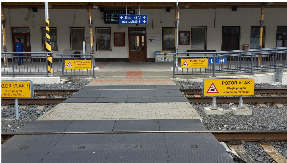
Foto č. 1 Centrální přechod v žst. Hanušovice, který sloužil jako referenční příklad pro ostatní centrální přechody v Evropě (foto: Autor)
